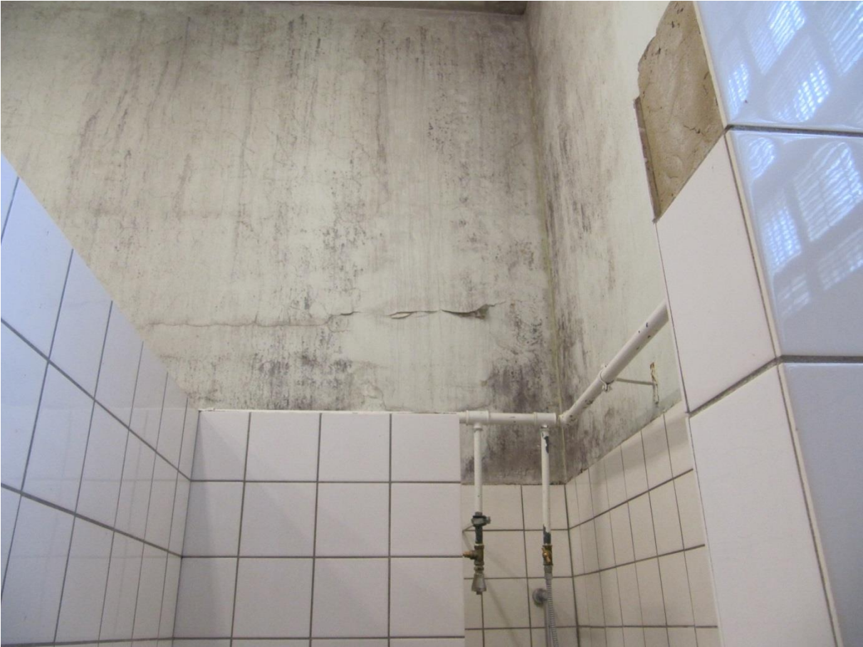
muren douches hospitaal
