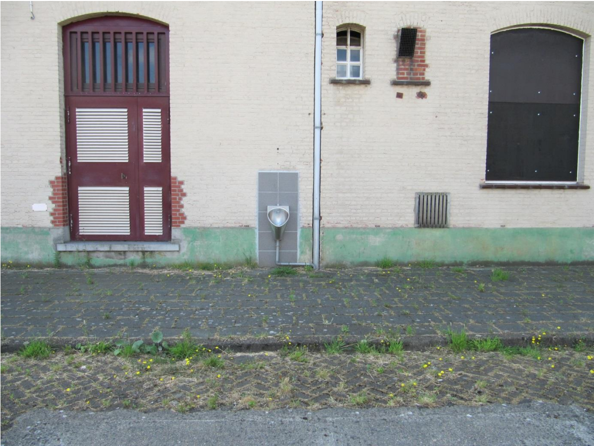
nieuw toilet op wandeling
