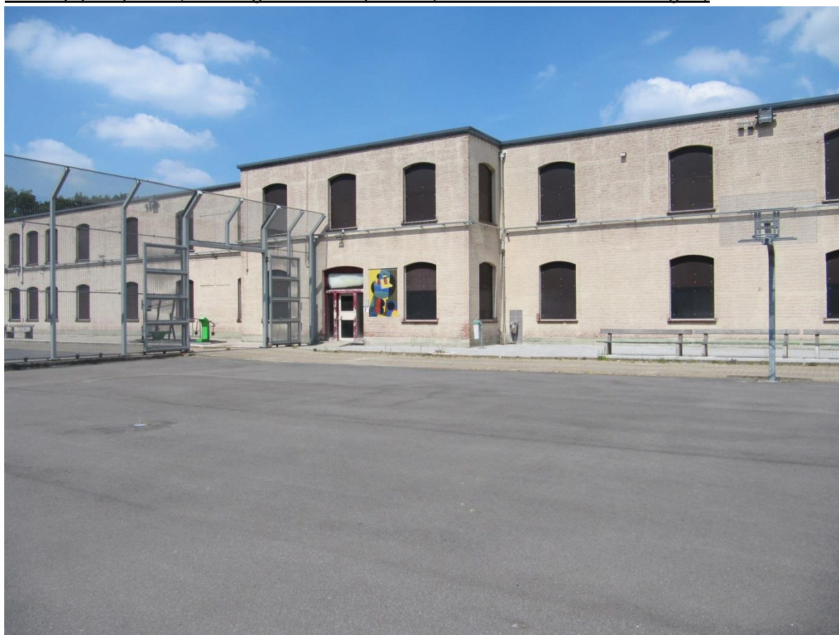
zicht op paviljoen F, buiten gebruik na opstand (brand en andere vernielingen)
