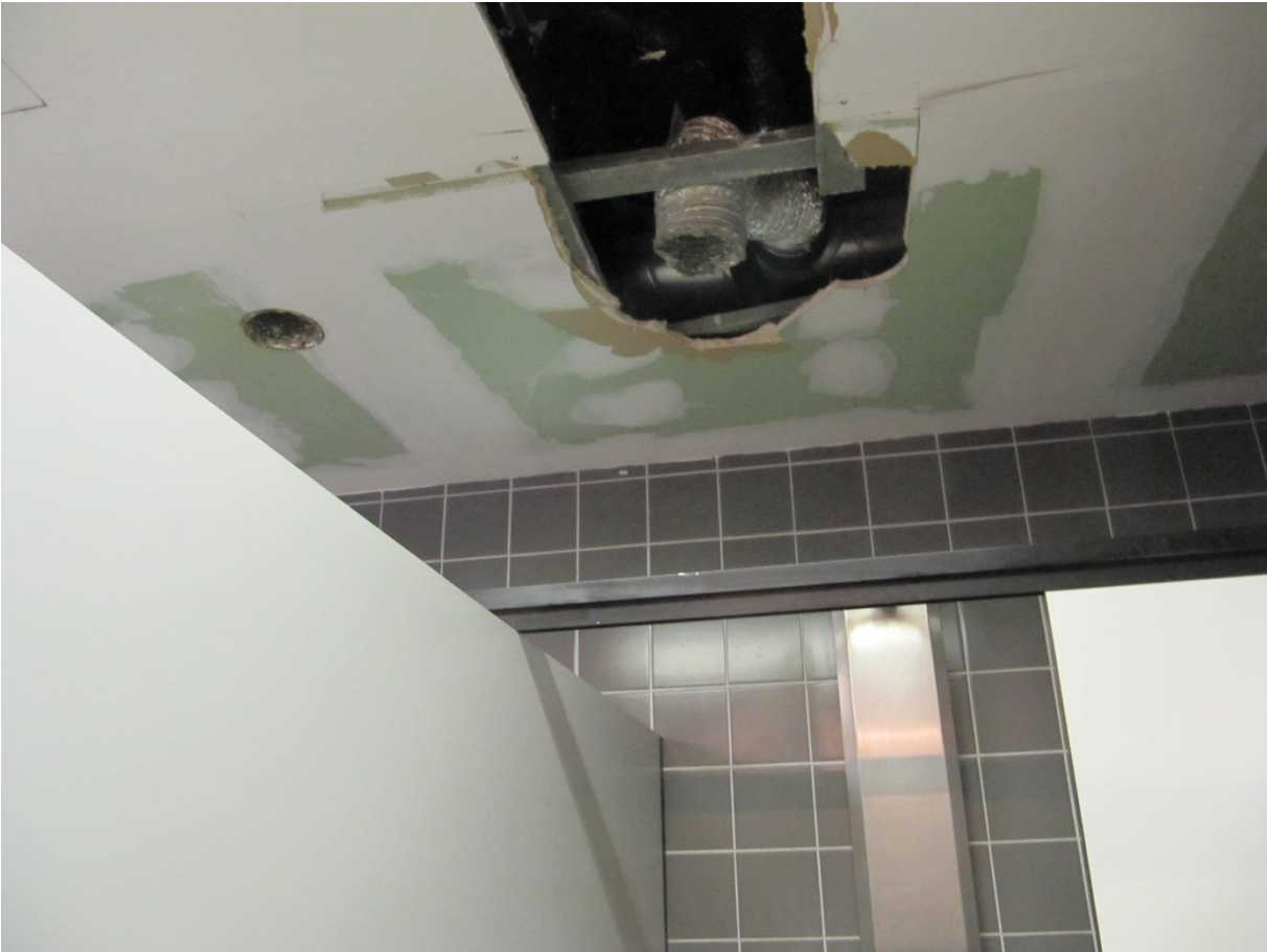
plafond doucheruimte Haven
